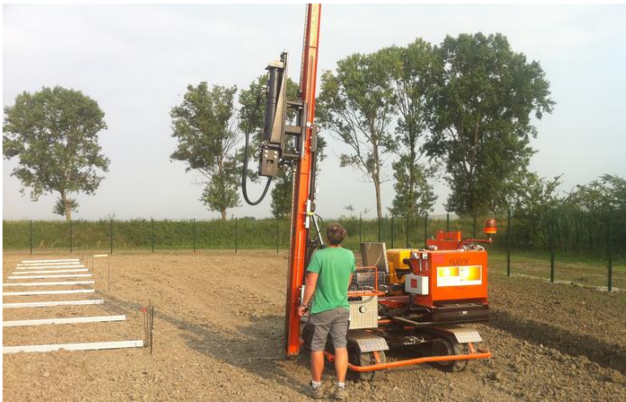
Zdjęcie nr 11. Budowa farmy fotowoltaicznej pod Parmą (Włochy), wykonanej w identycznej technologii jak planowana instalacja. Kafar do wbijania profili nośnych (na drugim planie – ułożone w miejscach wbicia)
