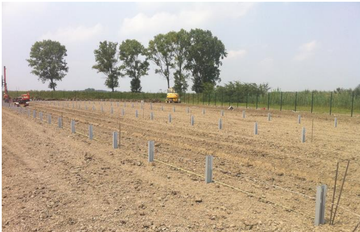
Zdjęcie nr 12. Budowa farmy fotowoltaicznej pod Parmą (Włochy), wykonanej w identycznej technologii jak planowana instalacja. Wbite w rodzimy grunt profile nośne.
