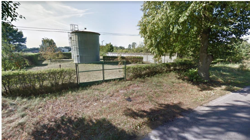
Fot. 3 Widok ul. Świeckiej
