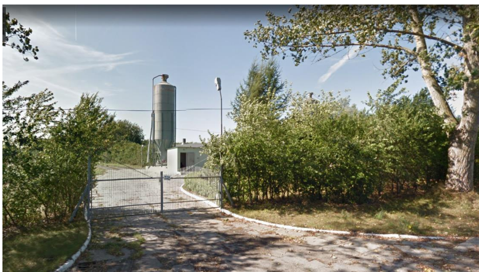
Fot. 1 Widok z ul. Świeckiej
